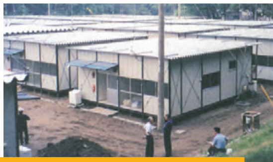
仮設住宅。一つの家族が一つの家に一緒に住めるように、建てられました
